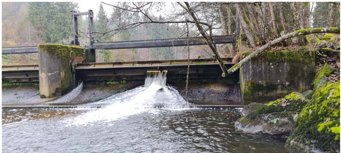
Bestehende östliche Wehrklappe mit bisheriger Restwasseröffnung.
