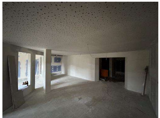
Ende Oktober noch Baustelle: Blick in den künftigen Gruppenraum (links ist der künftige Gruppennebenraum zu sehen)
